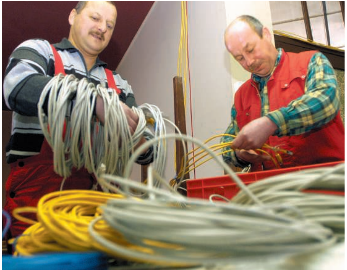
(Kabel-)Fleißarbeit: Bis Freitagabend machen Veranstalter Reinhard Eisold und Haustechniker Detlef Horbach das Kulturhaus Böhlen für die Lan-Party technisch fit. Foto: Andreas Döring
